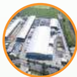
Plant Sidoarjo (Prambon)
